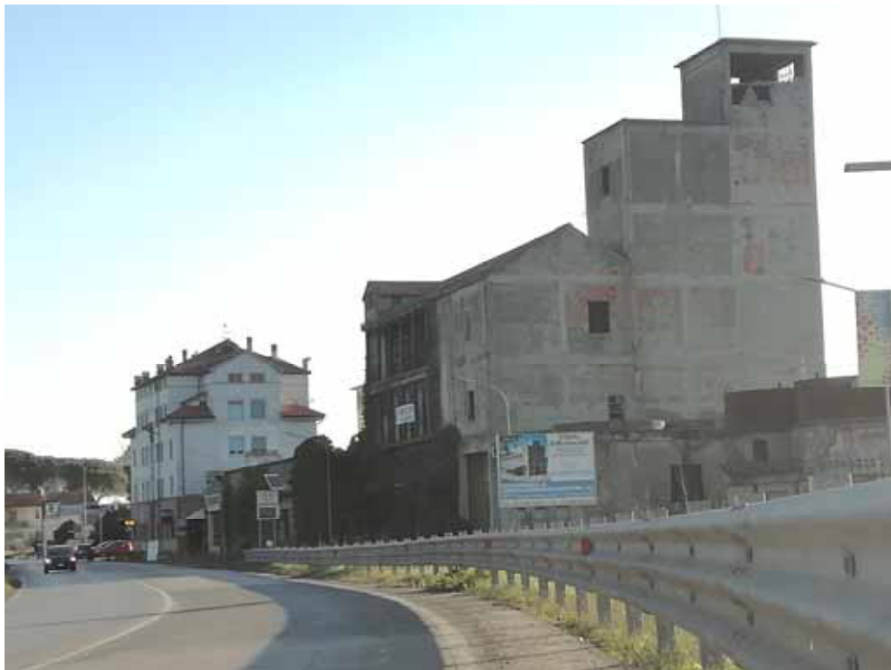
2_ strada regionale n.68, sulla destra il fabbricato oggetto di intervento.
