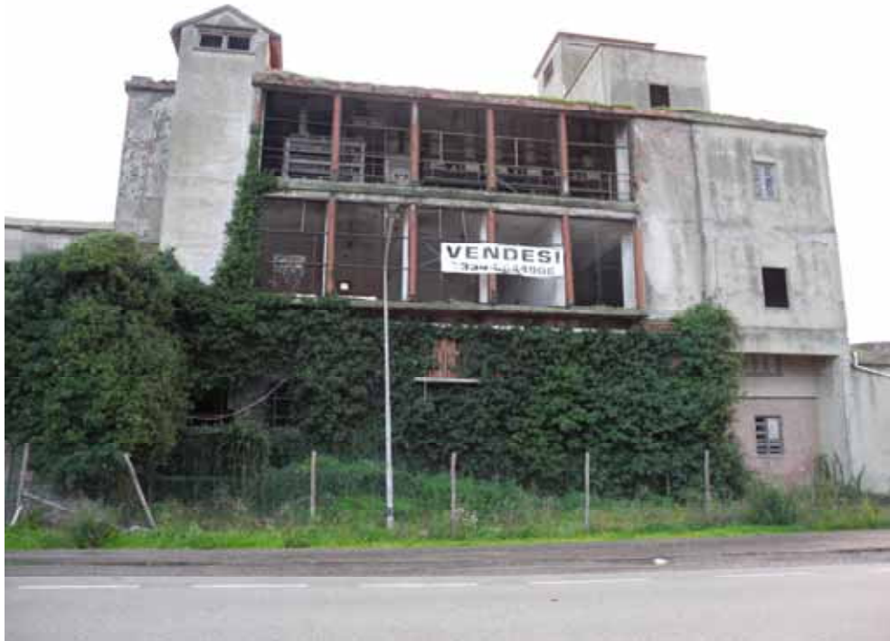
1_ la facciata dell'ex pastificio IMEP sulla strada regionale n.68
