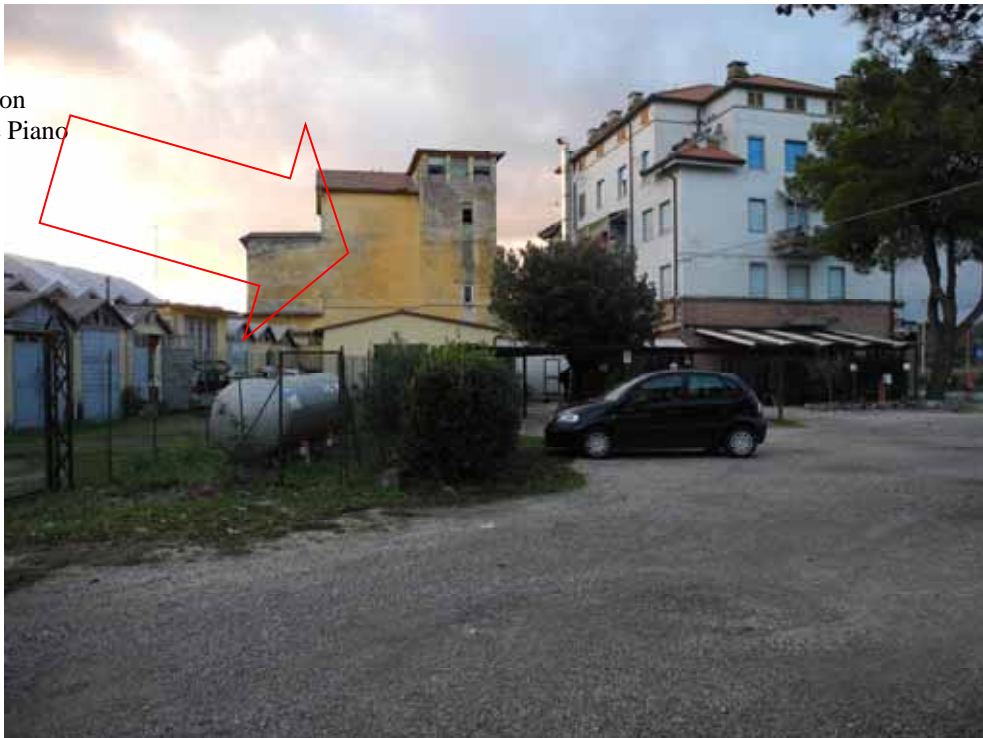
6_ Area di pertinenza esterna, sulla destra il fabbricato non oggetto d'intervento ad uso residenziale con attività di ristorazione al piano terra.
